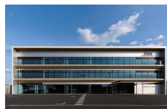
小山工場新総合事務棟
