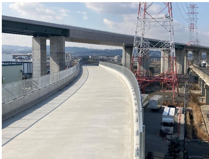
山城総合運動公園城陽線（城陽橋）橋梁
