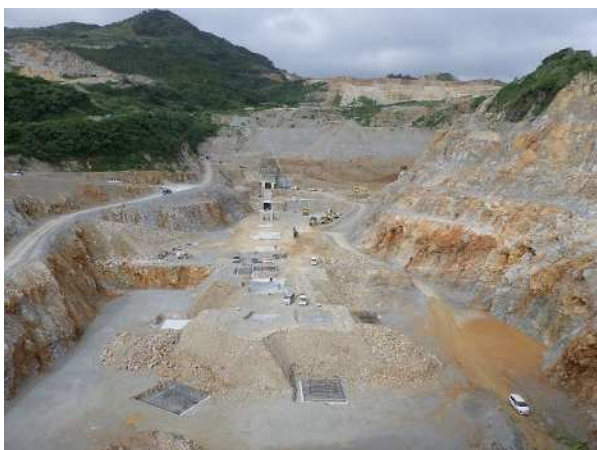
基礎工事 (2024年10月)
