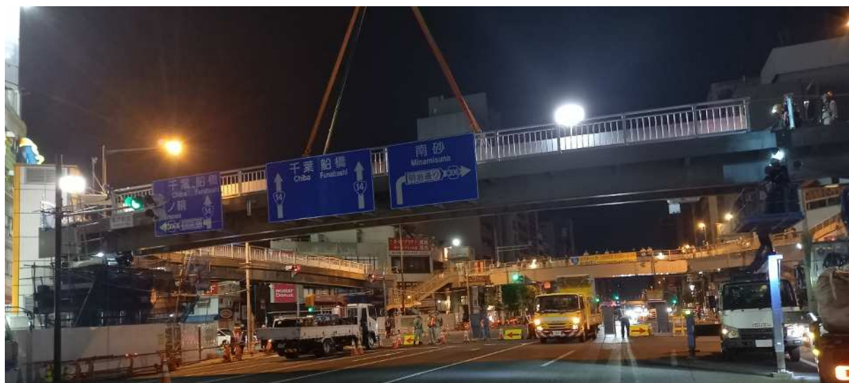
施工中の様子
