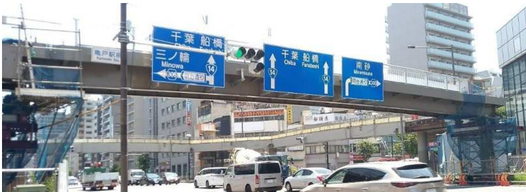
架替工事が完了した R 3 国道 1 4 号亀戸駅前歩道橋
