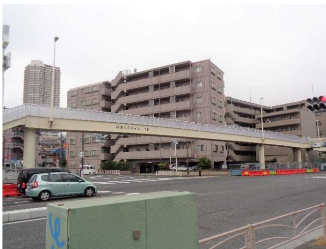
完成した国道1号新子安歩道橋
