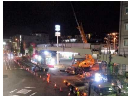
施工中の様子
